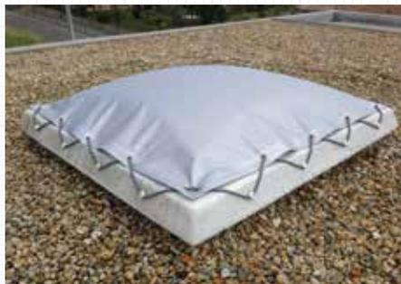
Dans le cas de coupoles, les écrans sont de forme octogonale définie en fonction des dimensions de la base et des bombés. Ils comportent alors 20 œillets pour un parfait maintien.
