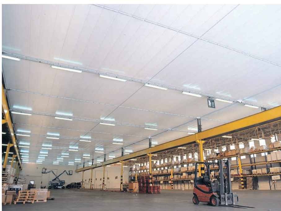
Plafond installé dans un local de très grande surface
