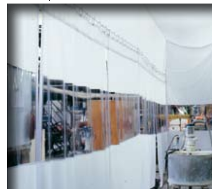
Tunnel de protection avec bande de vision.
